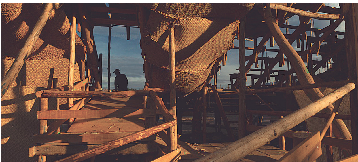
La Petatera.- Proceso de construcción de la plaza la Petatera. Alejandro González. 2020
