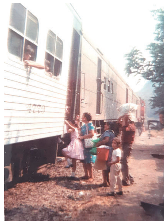
Antigua estación del tren en Platanar.
